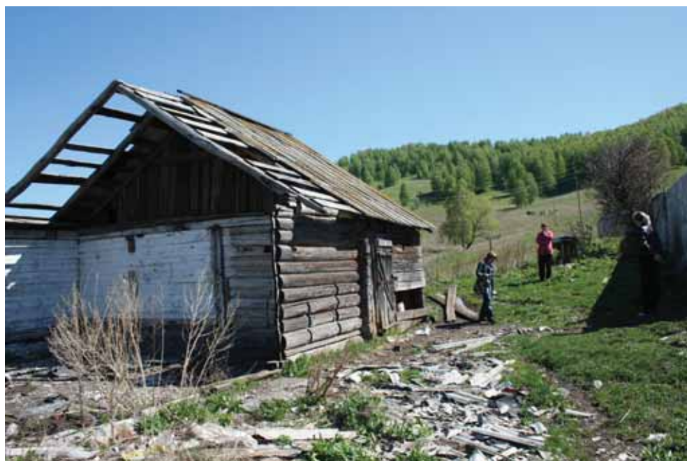
Заброшенный деревянный склад в с. Верх-Карагуж Майминского района, где хранились агрохимикаты
