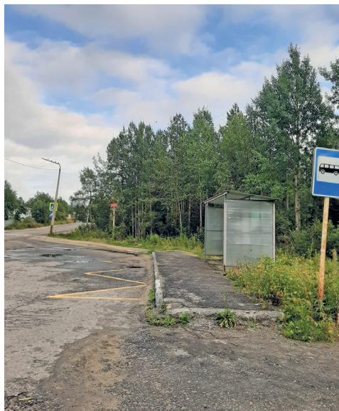
Остановка «ДРСУ» является конечной остановкой школьного автобуса (автобусный павильон установлен в рамках устранения нарушений по представлению)
