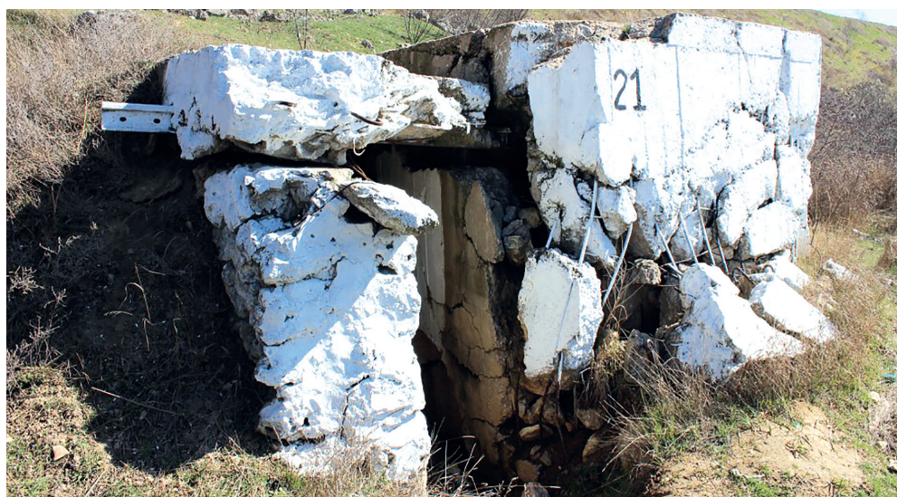
ДОТ № 21 (до начала работ)
