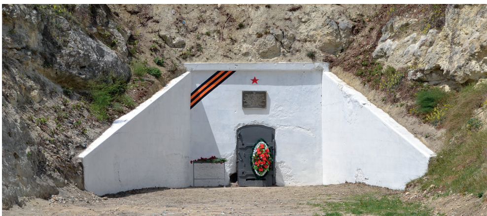
После завершения работ
