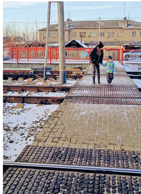
Пешеходный переход на станции Сокур в Новосибирской области до вмешательства прокуратуры (сверху) и после ремонта
